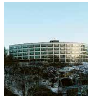
Solcellsanläggning: Micasas fastighet Katrumpstullen har fått solceller installerade under året.
