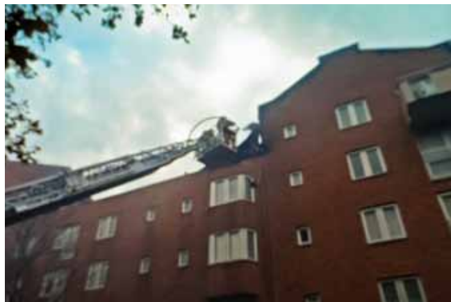
Den 1 november 2012 brann en bostadsfastighet i Skarpnäck ägd av Stockholmshem. Försäkringsskadorna beräknas uppgå till cirka 38 mnkr.
