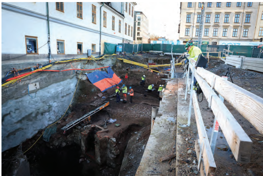
Stadsmuseets norra flygel till vänster. I schaktet syns stenhuset med ugnarna och enstensatt gata som ligger orienterade efter det gamla gatunätet. Foto: Johan Stigholt, SSM DIG024313.
